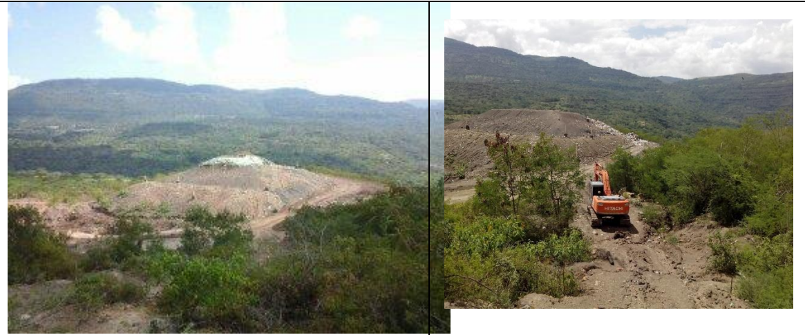
Vista general relleno sanitario EMPSACOL, San Gill, febrero de 2019.
